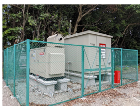
災害対策本部用の発電機
