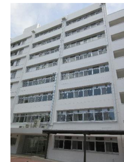
教育学部第3研究棟改修後の外観
