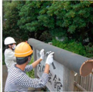
看板屋根の修理
