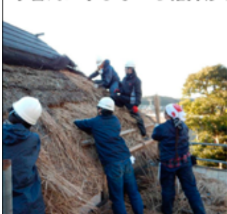
茅葺き屋根の修理
