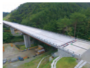
供用後の名称：田野畑普代大橋 写真提供：西武建設
