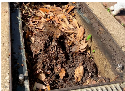
(経営学部・経済学部の中央通路に面した側溝)
